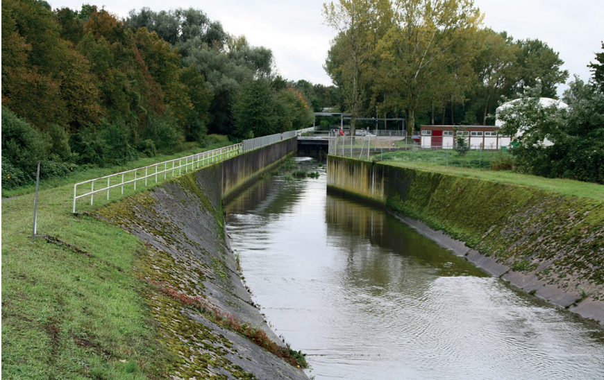
Das klare Wasser in diesem offenen Kanal kommt geradewegs aus einer Großkläranlage. Wasserproben hieraus wurden für die beschriebenen Reinigungstests verwendet.
